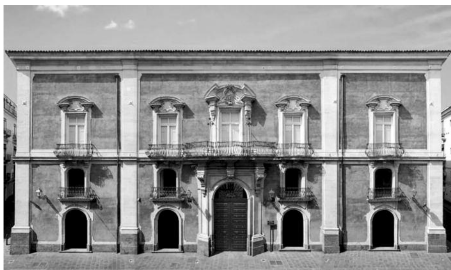
Fig. 16 - Prospetto sud di Palazzo Valle (CT).
