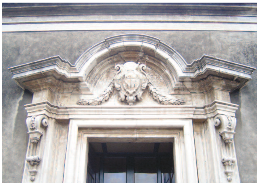
Fig. 13 - Particolare del portale d'ingresso di palazzo Biscari (CT).
