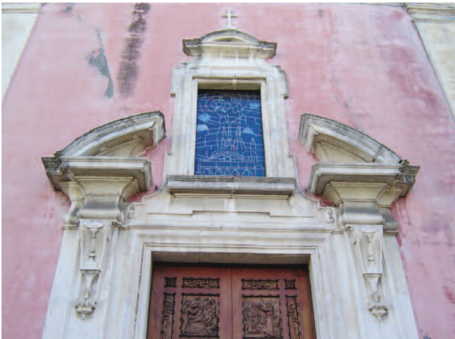
Fig. 6 - Particolare della facciata della chiesa madre di Gravina (CT).
