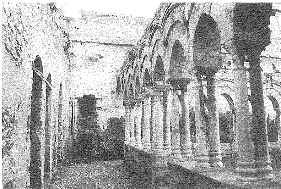
Fig. 17 - Palermo, Chiostro di San Giovanni degli Eremiti: particolare della corsia Sud.
