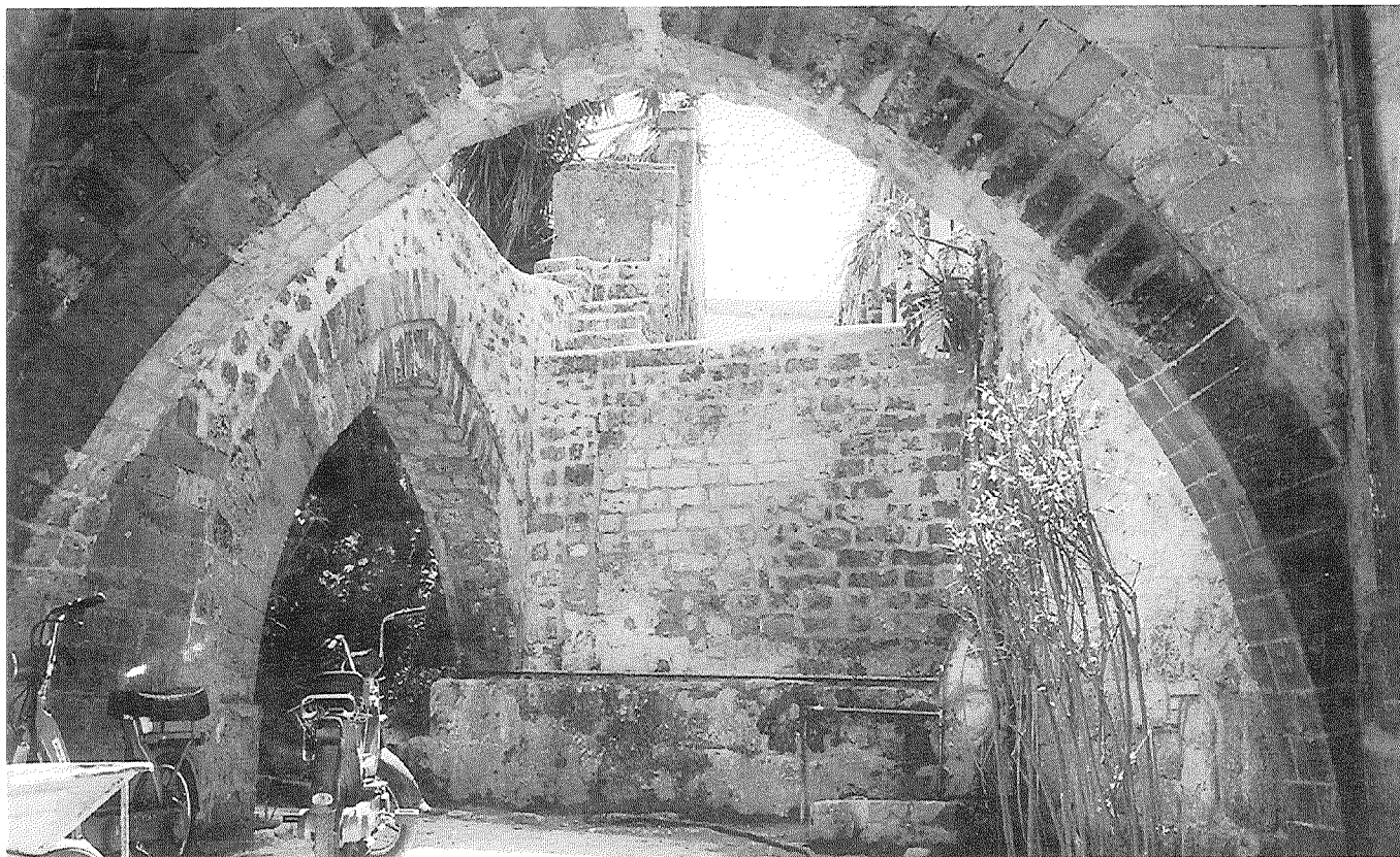
Fig. 28 - Palermo, Complesso di San Giovanni degli Eremiti: particolare delle strutture del monastero benedettino demolito nel 1875.
