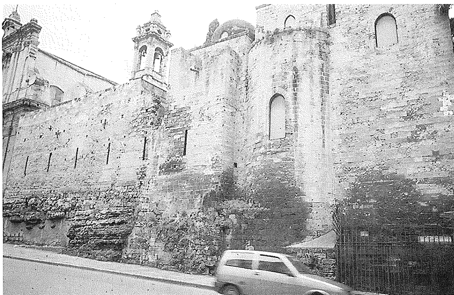
Fig. 3 - Palermo, Complesso di San Giovanni degli Eremiti: sala adiacente alla Chiesa dal lato del Diaconicon, e fronte orientale della chiesa.
