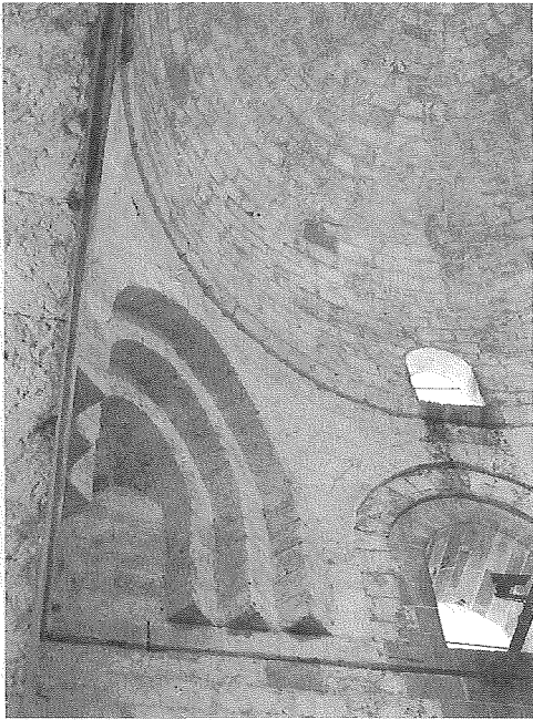
Fig. 9 - Palermo, Chiesa di San Giovanni degli Eremiti: particolare del sistema dei raccordi a trombe angolari.
