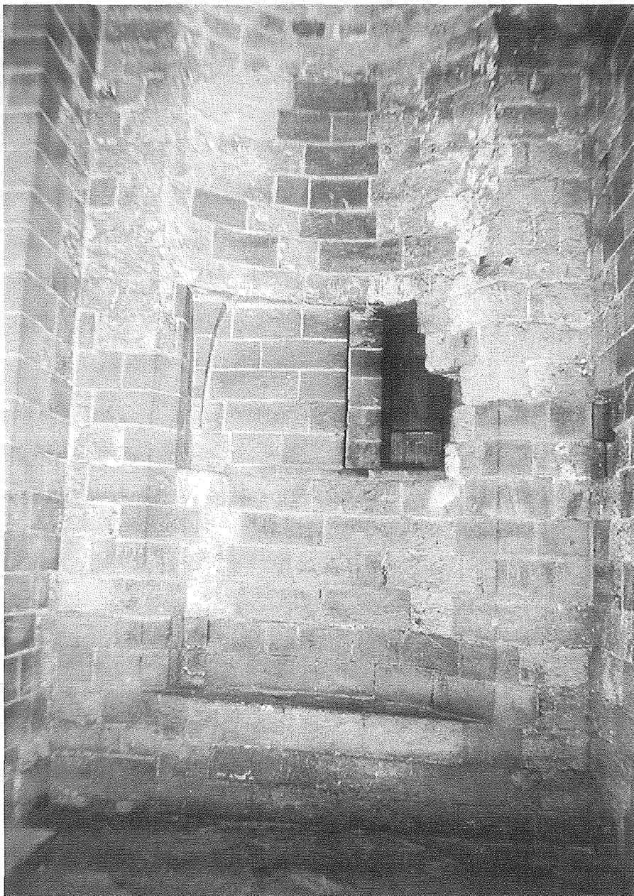
Fig. 23 - Palermo, Chiesa di San Giovanni degli Eremiti: particolare dell'abside del diaconicon con le tracce dell'attacco della volta a crociera e della feritoria.
