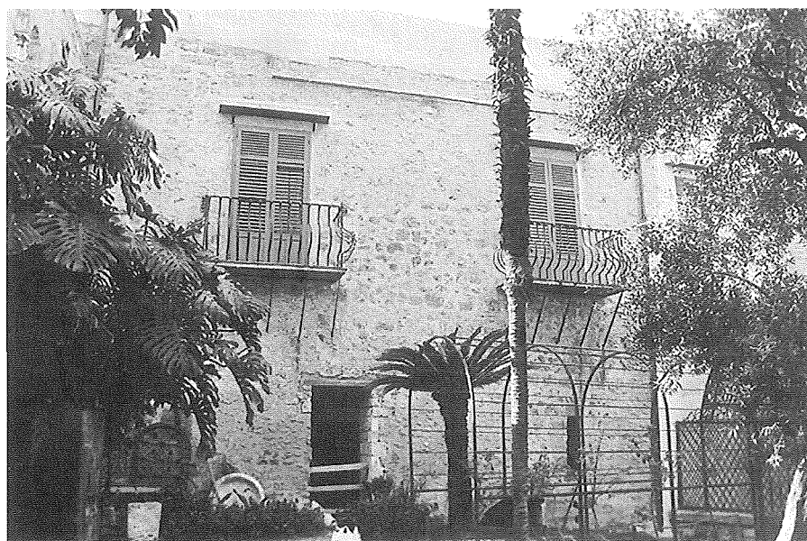
Fig. 4 - Palermo, Complesso di San Giovanni degli Eremiti: edificio a Nord del chiostro.
