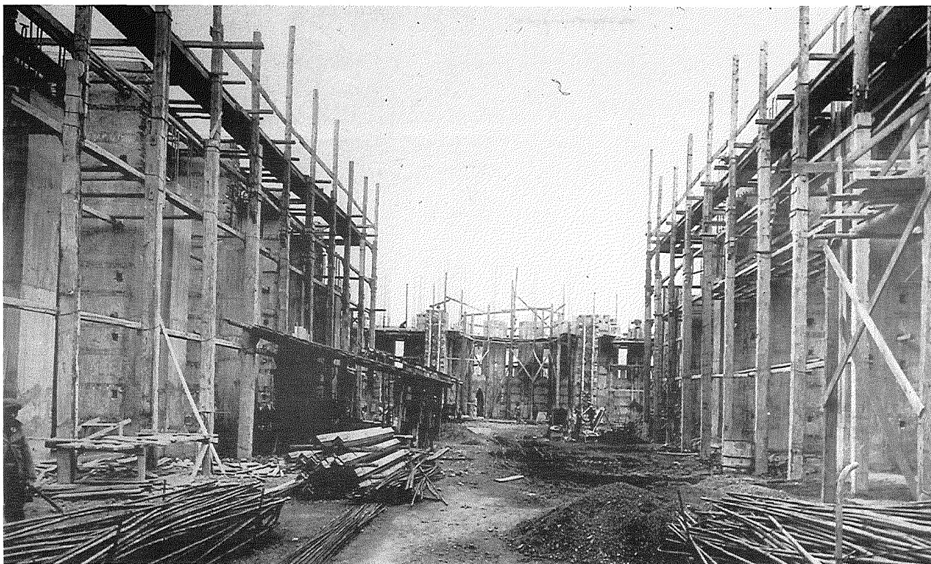
Fig. 20 - Messina, chiesa di San Francesco d'Assisi: un momento intermedio della ricostruzione integrale (le pareti della navata, e in fondo, le absidi risorgenti, ancora a mezza altezza).
